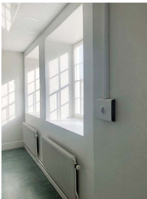
Rys. 5. Sala lekcyjna z zastosowaniem elementów systemu zarządzania klimatem wewnętrznym WISE
