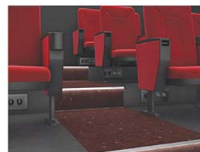
Nawiewnik waporowy montowany w stopniach schodów
