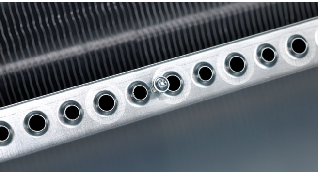
Kuva 9. Suutin H. Lista irrotettuna
