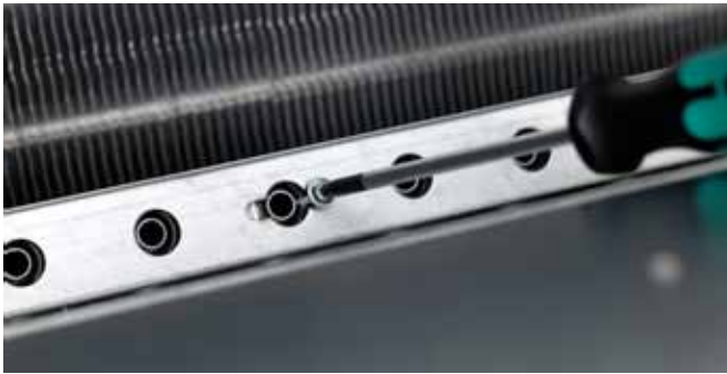
Kuva 7. Säädetty suutin L
