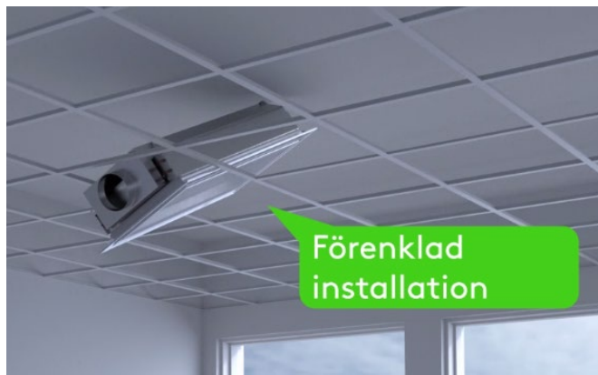
Figur 13. Installation i befintligt T-bärverk
