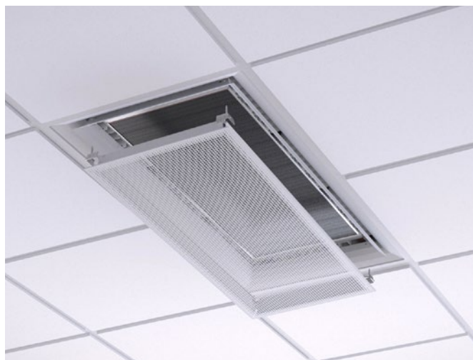
Figur 14. Demontering av underplåt för åtkomst av batteriet
