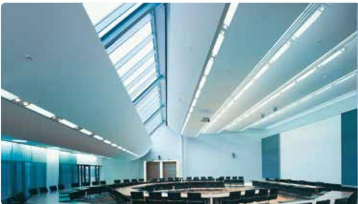
Fertiggestellte Heiz-/Kühldecke in leicht gebogener Ausführung (Sonderkonstruktion)
