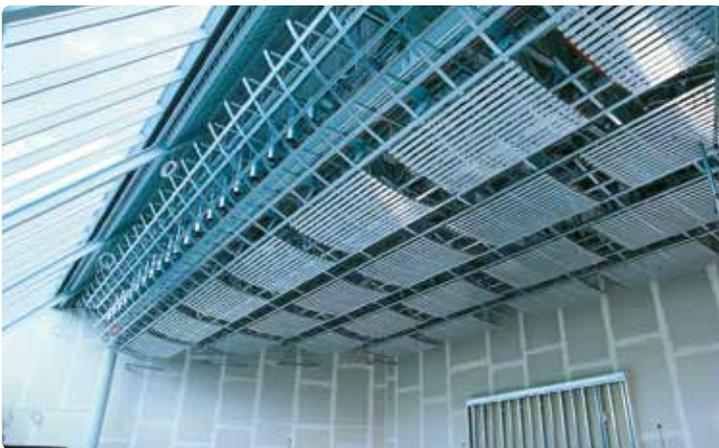
Heiz-/Kühldecke vor der Beplankung mit Thermoplaten
