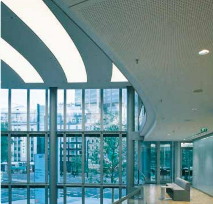
Das Gipskarton-Heiz-/Kühldeckensystem VARICOOL Uni – formschön an die Architektur und die Lichtdecke angepasst
