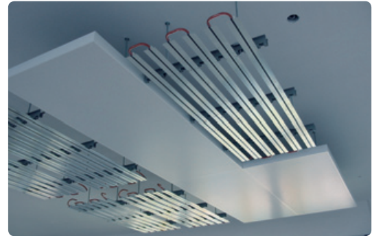
Mit Gewindestangen abgehängte Heiz-/Kühlregister mit Magnettechnik. Nachträglich montierte Deckenplatten ergeben die fertige Deckeninsel
