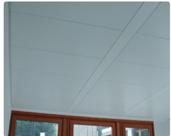
Metallblech-Heiz-/Kühldecke mit VARICOOL Spectra in Bandrasterkonstruktion
