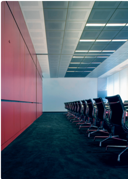
Kassetten-Heiz-/Kühldecke im Standardrastermaß 625 mm mit Sonderperforation und Einbauleuchten
