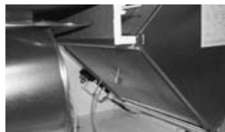
Tunnistimen paikka on merkitty kennoon (n. 5 cm kennon sivukulmasta ja n. 10 cm etureunasta)
