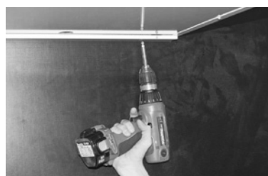
W100 skruvas fast genom höljet i väggfästet.
