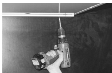
W80 skrus fast i veggfestet gjennom kabinettet.
