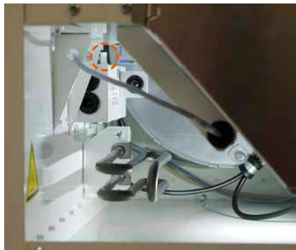
Jälkilämmitysvastuksen yllilämpösuojan palautuspainike ( vain sähkömallit )
