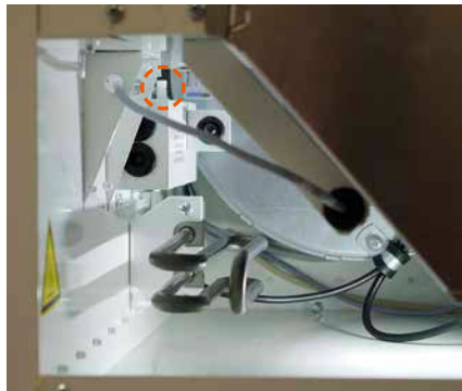
Återställningsknapp för övertemperaturskyddet på eftervärmens luftvärmare ( endast modeller med elektrisk luftvärmare )
