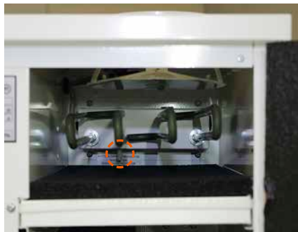
Tilbakestillingsknapp for overtemperaturvernet på forvarems luftvarmer
