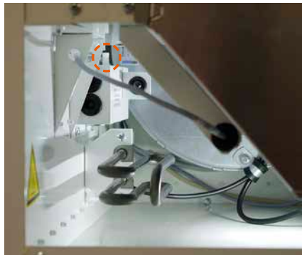
Tilbakestillingsknapp for overtemperaturvernet på ettervarems luftvarmer (bare modeller med elektrisk luftvarmer)
