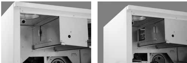
Bypass am Wärmetauscher vorbei: Die Klappe ist im Winter geschlossen und im Sommer geöffnet.
