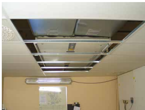
w pomieszczeniu, podwieszana pod sufitem
