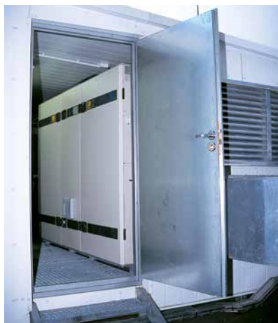
na dachu budynku, w dodatkowej obudowie
