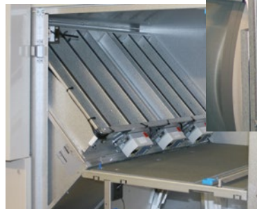
Intercambiador de calor de placas de flujo cruzado
