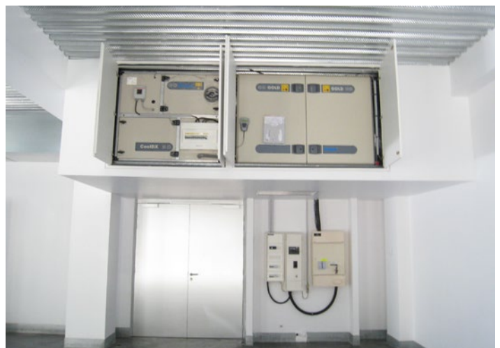
Ejemplo de instalación de unidad GOLD con unidad refrigeradora: compacta y sin ocupar espacio en el suelo
