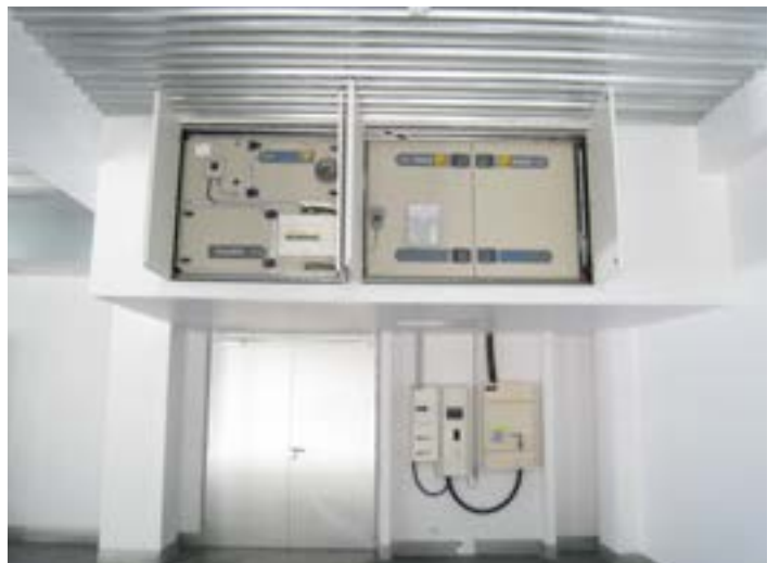
Eksempel på pladsbesparende og kompakt installation af GOLD med kølemaskine
