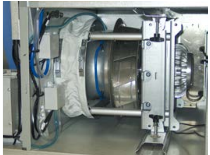
Energieffektive ventilatorer
