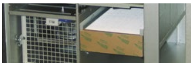
Kassettenfilter der Filterklasse ePM1 50% (F7).
