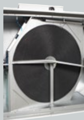
Rotierender Wärmetauscher RECOeconomic
