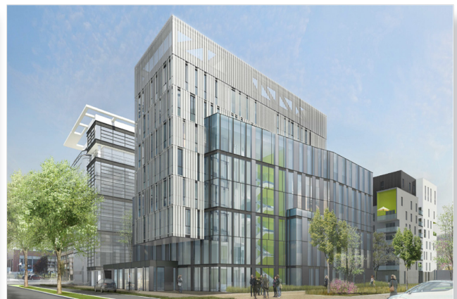
Immeuble Vista, Rouen GOLD RX , GOLD SD , poutres climatiques PARASOL et ADRIATIC , armoires de climatisation DATATECH , refroidisseurs de liquide et pompe à chaleur BETA REV , groupes à condensation par air EPSILON ECHOS
