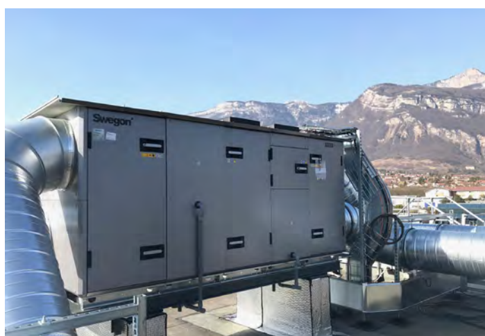
Soitec, Bernin Centrale de traitement GOLD RX HC (avec pompe à chaleur intégrée)
