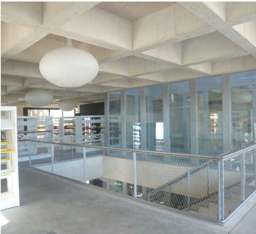
Médiathèque Montaigne, Frontignan Centrales de traitement d'air GOLD RX, poutres climatiques PACIFIC et modules de confort PARASOL
