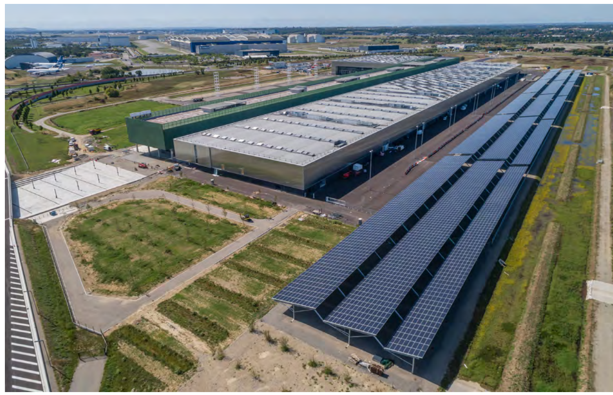
Parc des expositions, Toulouse Centrales de traitement d'air GLOBAL PX
