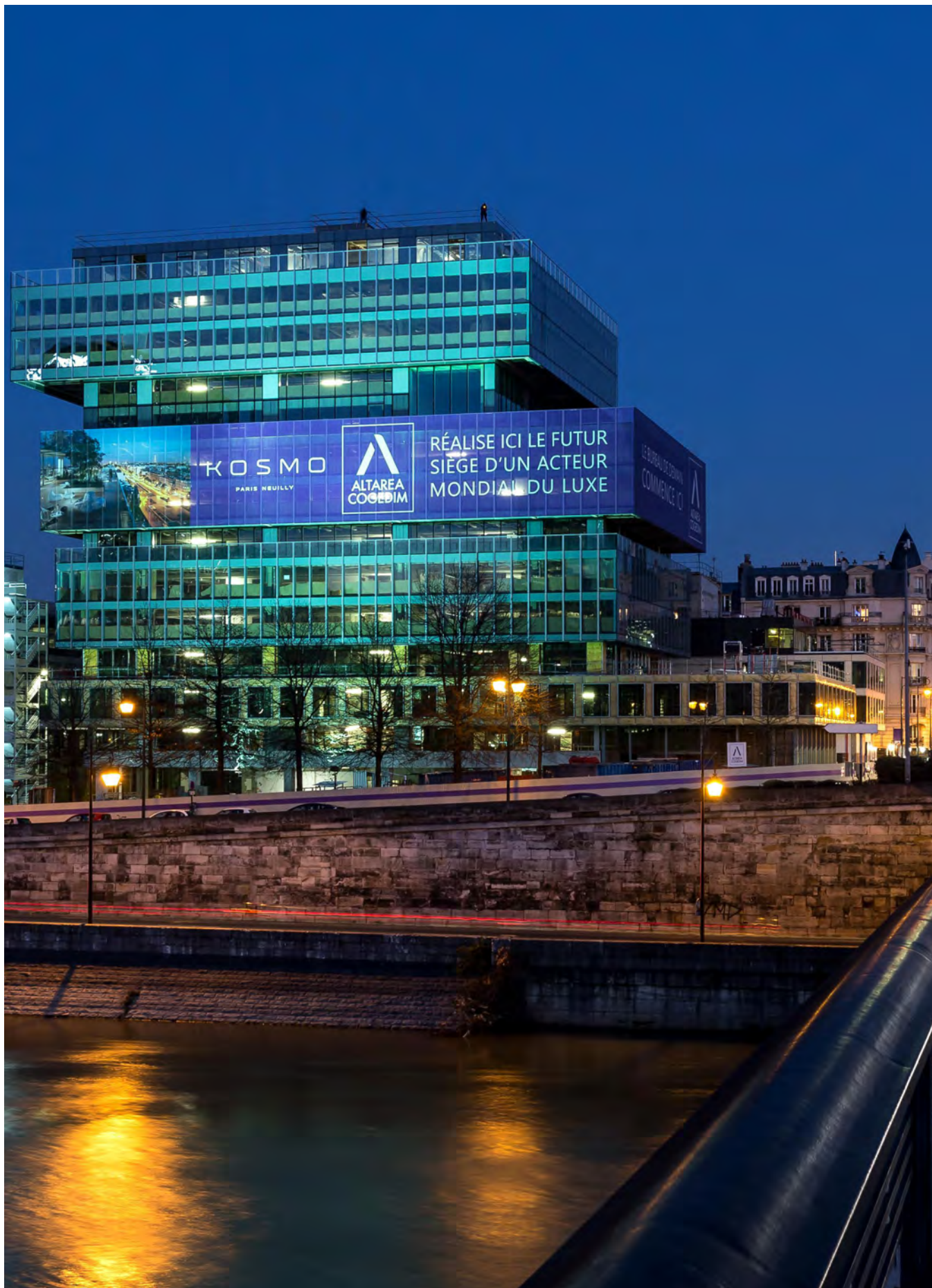
KOSMO, Neuilly-sur-Seine 3 pompes à chaleur 4 tubes air/eau Omicron V Evo
