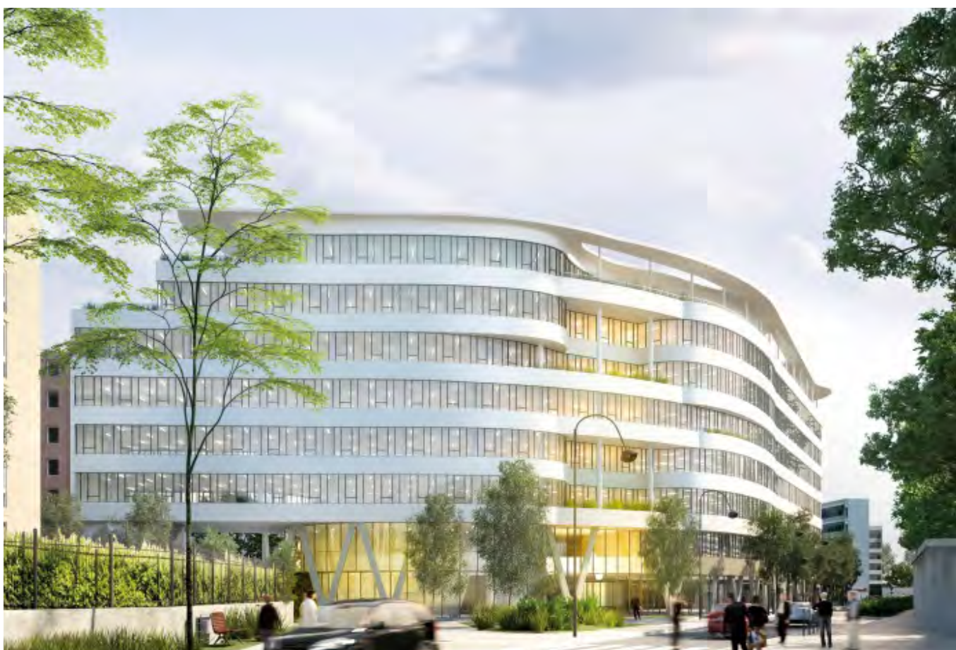
Convergence, Rueil-Malmaison • thermofrigopompes OMICRON REV S4
