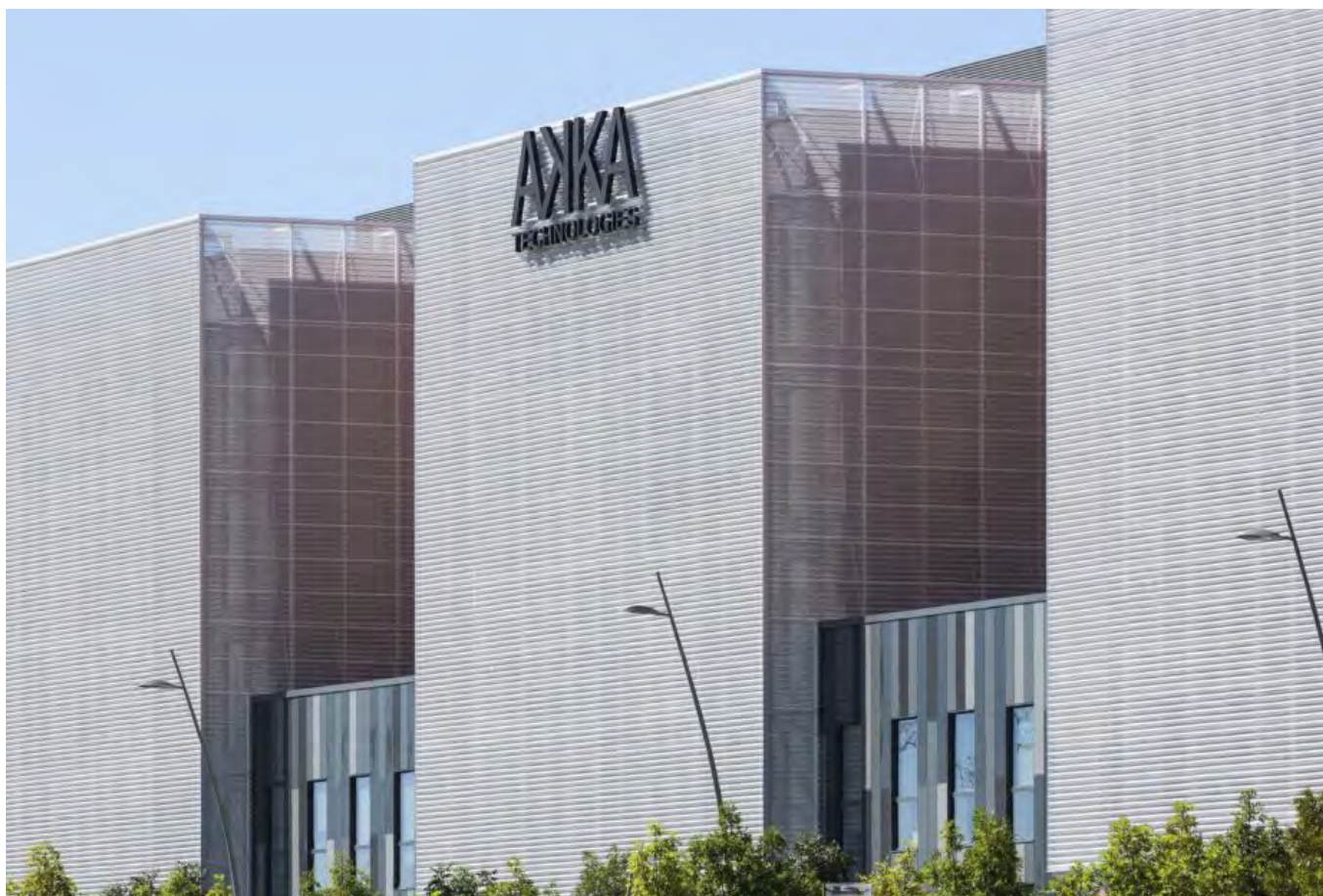
Akka Technologies, Blagnac • centrales de traitement d'air double flux GOLD RX, pompes à chaleur air/eau, TETRIS 2A LN HP, pompe à chaleur à condensation par air ZETA ECHOS A LN HP 12.2
