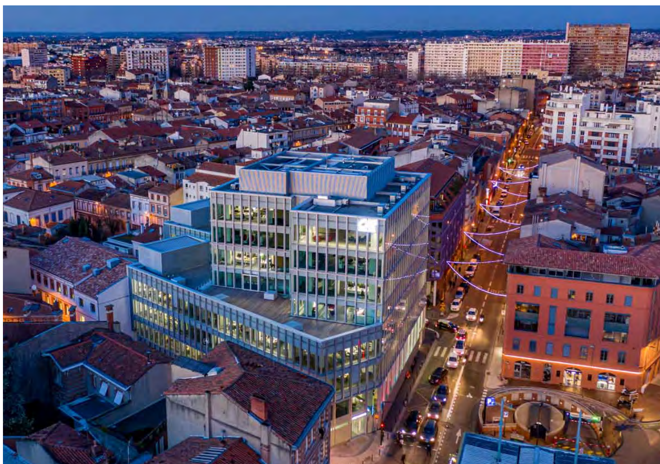
Crédit Agricole, Toulouse • Thermofrigopompe OMICRON Rev S4 et centrales de traitement d'air double flux GOLD RX
