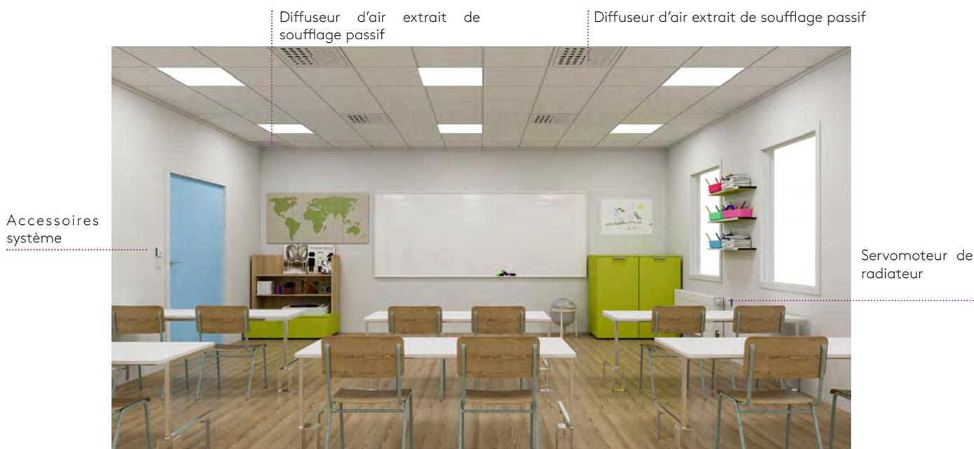
Solution pour salle de classe. Registre WISE distinct pour air soufflé et air extrait, au moins un diffuseur d'air soufflé et un diffuseur d'air. La pièce bénéficie d'un débit d'air soufflé et d'air extrait variables (pression équilibrée).
