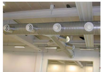
Les diffuseurs à déplacement d'air sont conçus pour fonctionner efficacement à basse vitesse. Pour garantir un bon confort dans le local, la plupart de ces appareils sont équipés du système de distribution flexible Varizon® de SWEGON qui permet de modifier la direction de l'air. Aussi dans les locaux à grande hauteur sous plafond, des économies d'énergie importantes peuvent être réalisées en utilisant les diffuseurs à déplacement d'air SWEGON dotés de ce système.
