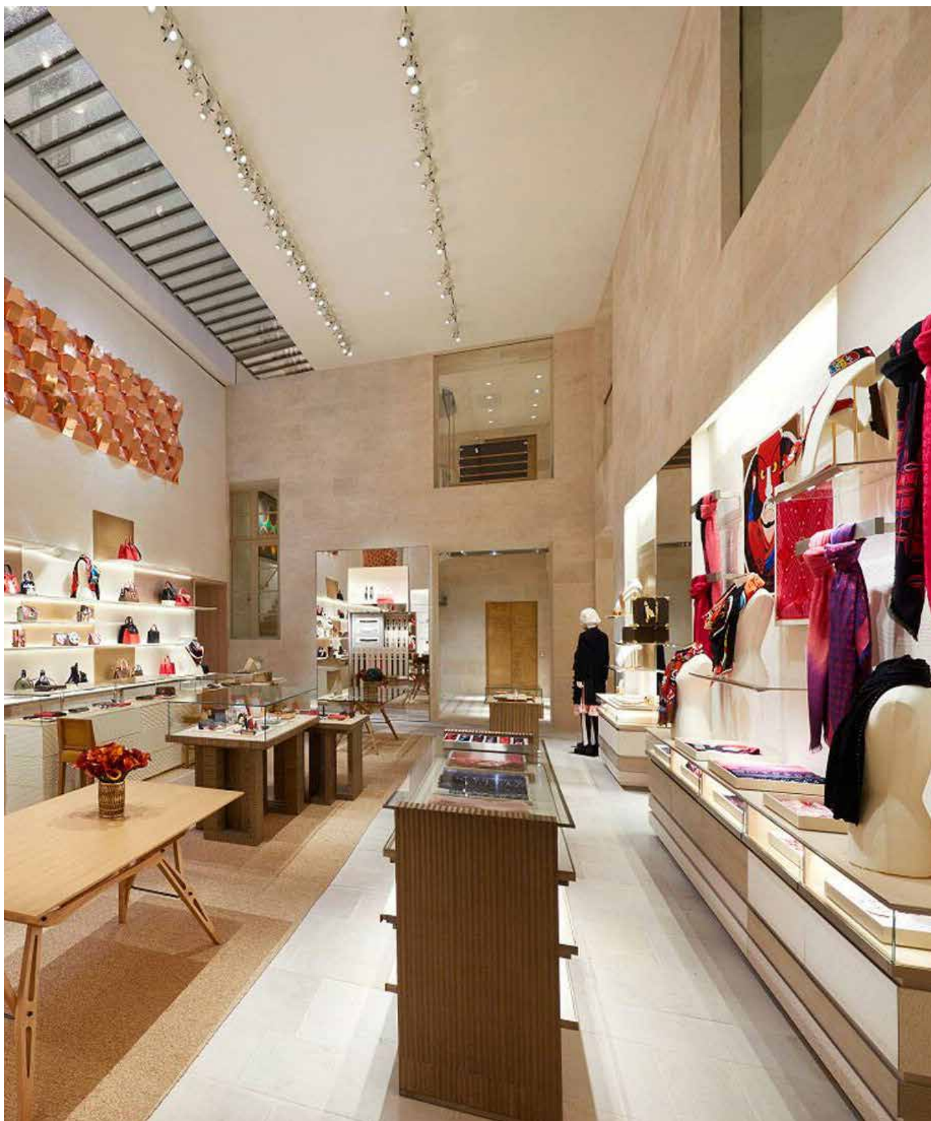
Showroom LVMH, Paris Centrales de traitement d'air GOLD et armoires de climatisation DATATECH
