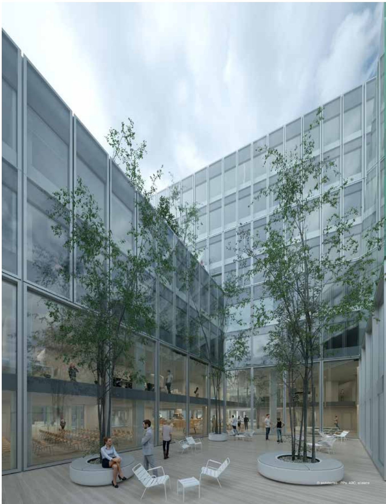
Crédit Agricole, Toulouse Thermofrigopompe OMICRON Rev S4 et 9 centrales de traitement d'air double flux GOLD RX
