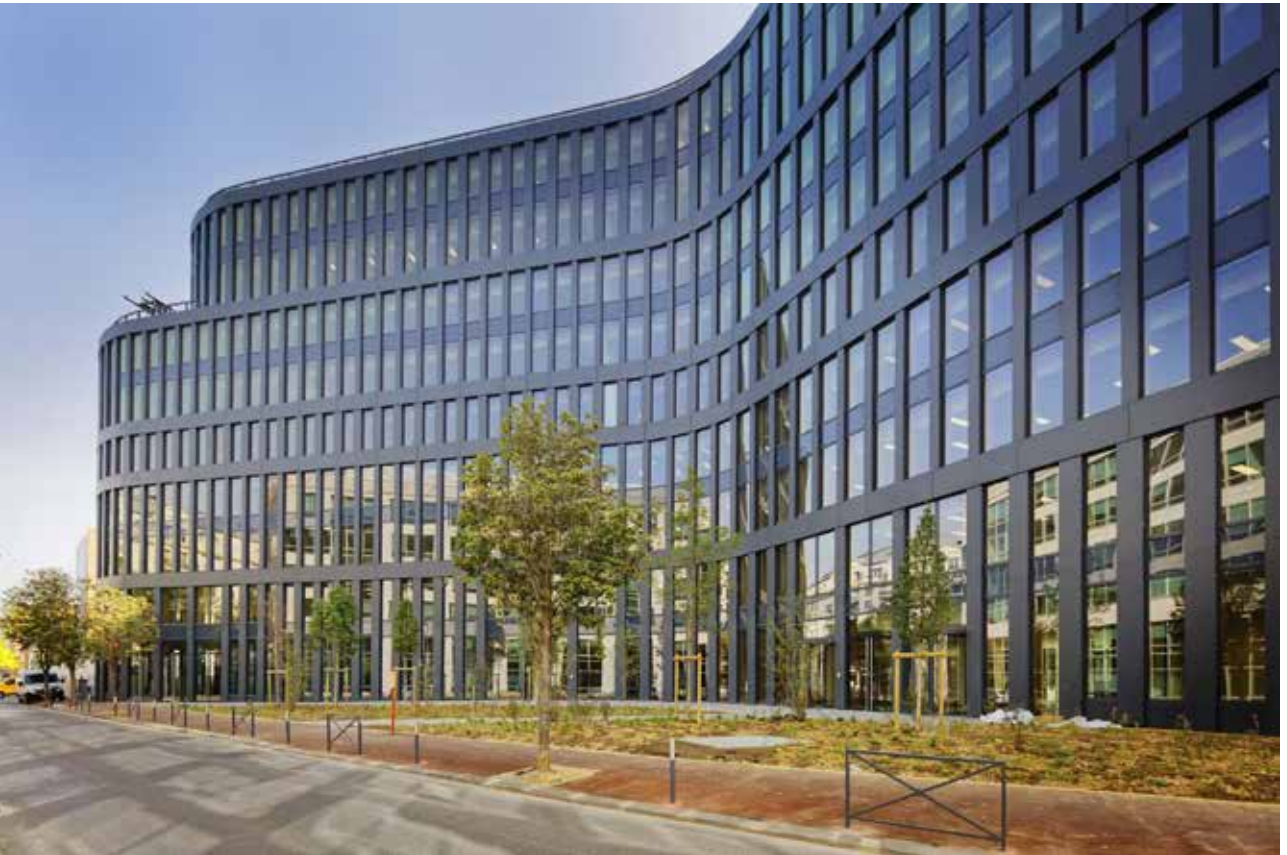
Immeuble Be Issy, Issy-les-Moulineaux 2 pompes à chaleur réversibles Tetris 2A
