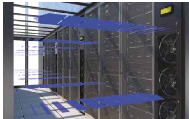
Distribution d'air une allée froide
