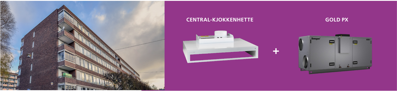
Leilighetsbygg med sentral avtrekksvifte.
