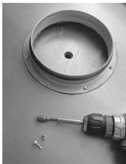
6. Skruva fast påsticket med självborrande skruv
