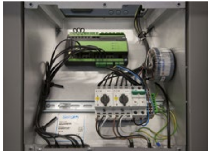
Tous les composants électriques et l'électronique de commande sont installés dans une armoire spéciale située dans le module central.
