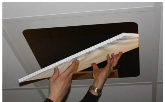
Figur 2. Montage av RASTER i ADAPTER.
