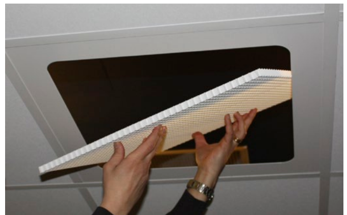
Kuva 2. Säleikön asennus ADAPTERiin.
