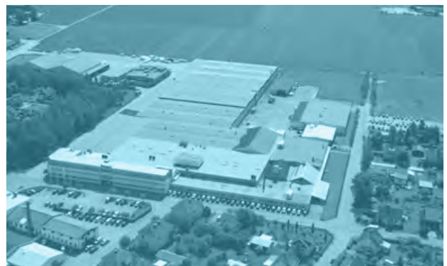
Kvänum, Schweden: Produktionsstandort der GOLD-Lüftungsgeräte
