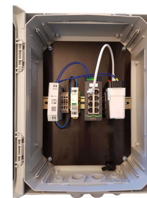
Abbildung 6: INSIDE Connect im Schaltschrank mit Schalter installiert.
