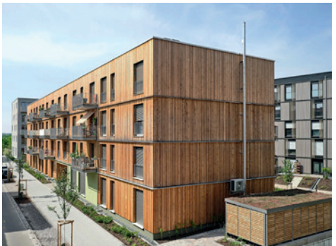
OIKOS Mannheim, bâtiment hybride – construction de logements
