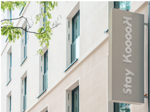
Ristrutturazione energetica con soluzione nella spalletta della finestra
