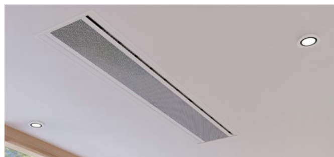
Figura 9. REACT Pacific con telaio in cartongesso, PACIFIC T-FPB.
