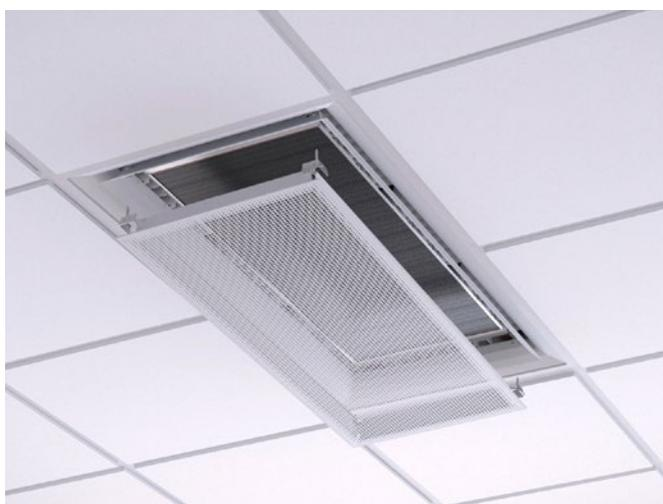
Figura 12. Rimozione della piastra anteriore per accedere alla batteria
