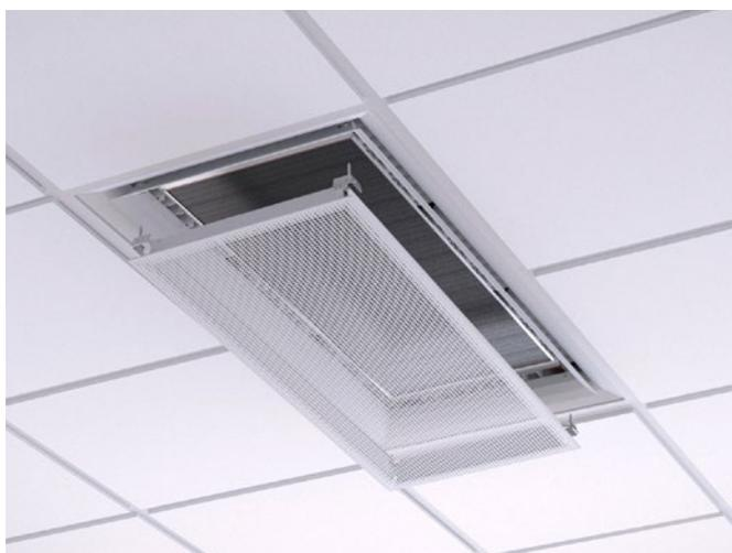
Figure 12. Dépose de la sous-face pour accéder à la batterie
