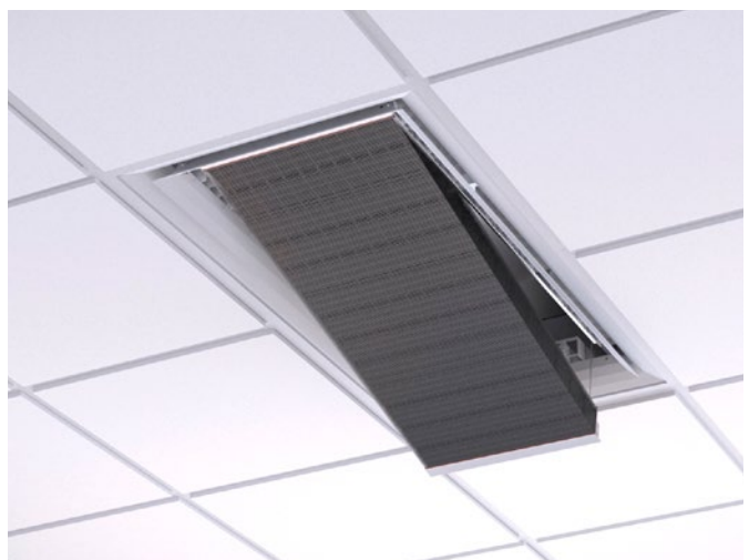
Figura 13. Retirada del panel visto y extracción de la batería para limpiar con precisión en el caso de que haya requisitos de higiene elevados.
