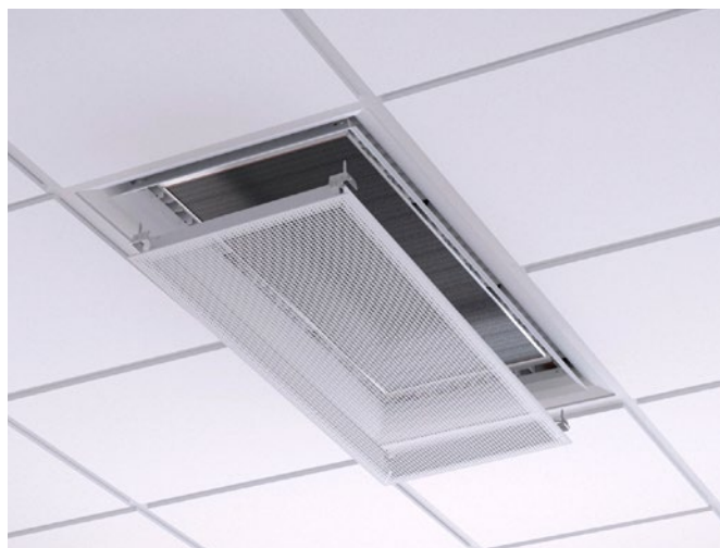
Figur 12. Demontering af underplade for adgang til varme-/kølefladen
