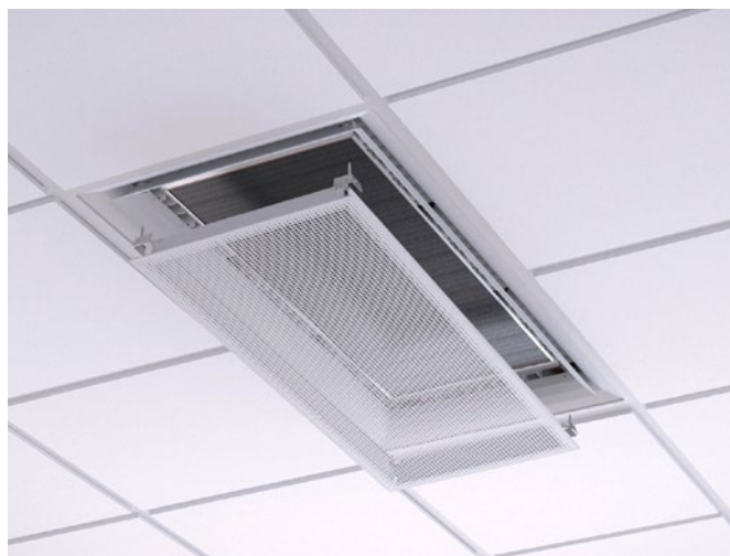
Figur 17. Demontering av underplate for tilgang til batteriet
