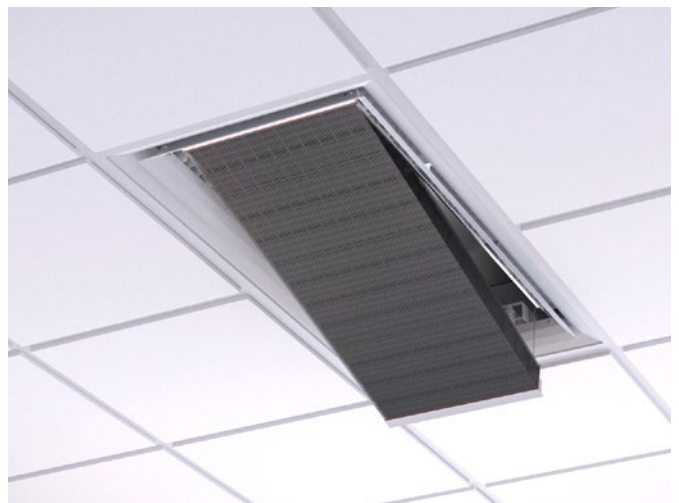
Kuva 18. Pohjalevyn irrotus ja patterin laskeminen huolellista puhdistusta varten korkeiden hygieniavaatimusten yhteydessä.
