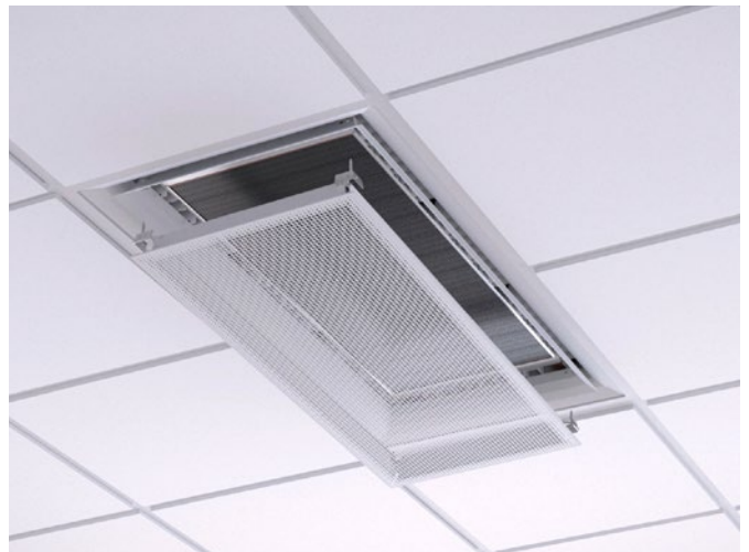
Kuva 17. Pohjalevyn irrotus patteriin käsiksi pääsyä varten
