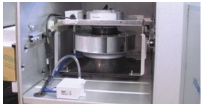
Suoravetoiset, EC-moottoreilla varustetut puhaltimet.
