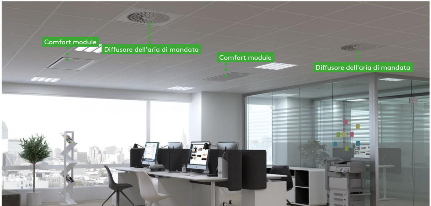
Il rilevamento della presenza e le misurazioni della temperatura vengono effettuate nel diffusore dell'aria di mandata o nel comfort module attivi, questi effettuano una co-regolazione in modo tale che venga fornita all'ambiente la corretta quantità d'aria oltre a raffreddamento e/o riscaldamento, in modo da ottenere il clima ambiente impostato.
