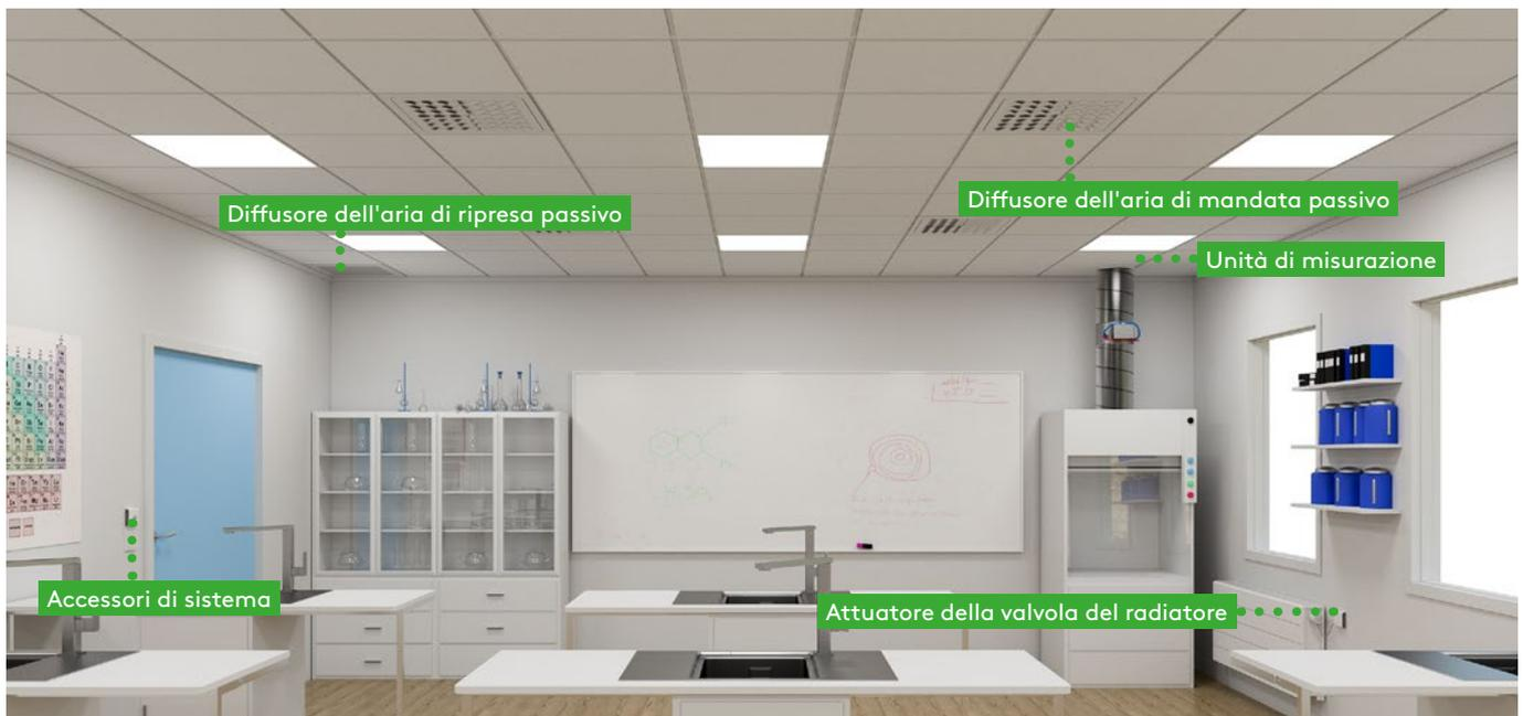
La misurazione della temperatura dell'aria ambiente viene effettuata nella serranda dell'aria di ripresa e il sistema regola la quantità di aria di mandata e di ripresa nell'aula, in modo da ottenere la giusta climatizzazione ambiente.
