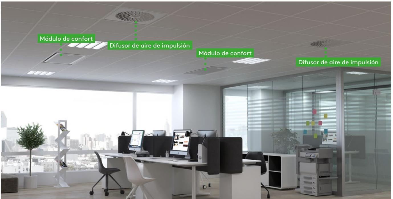
La detección de presencia y las mediciones de temperatura se realizan en el difusor de aire de impulsión activo o el módulo de confort, que se corregulan para suministrar la cantidad correcta de aire a la sala, así como la refrigeración y/o la calefacción para lograr la climatización interior establecida.
