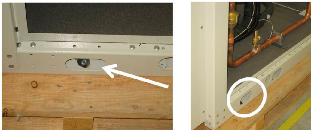
Fig. 4 Detaljer över skruvlägen för fastsättning vid pallen
