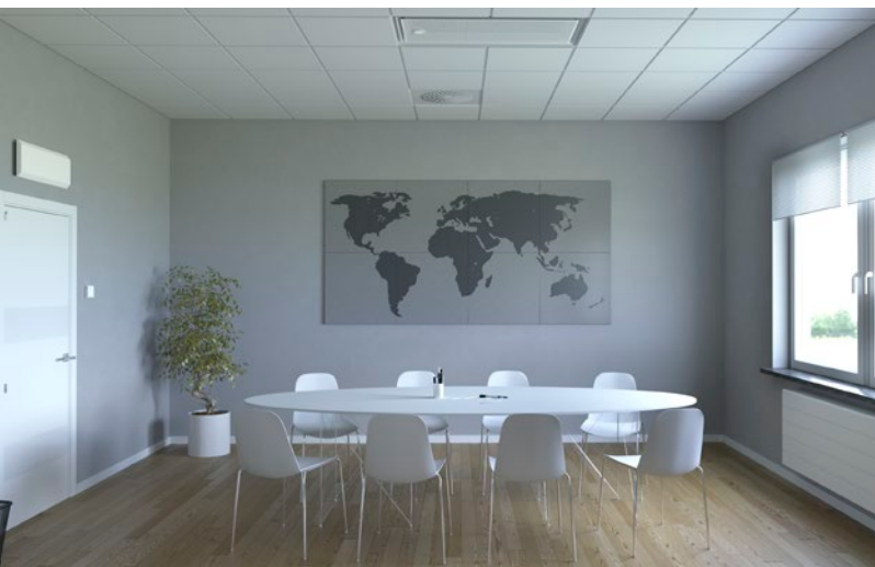
Sala konferencyjna z przetłaczniakiem wyboru wartości zadanej i regulacją powietrza sterowaną zapotrzebowaniem, a także chłodzeniem na bazie wody i sterowaniem grzejnikami.
