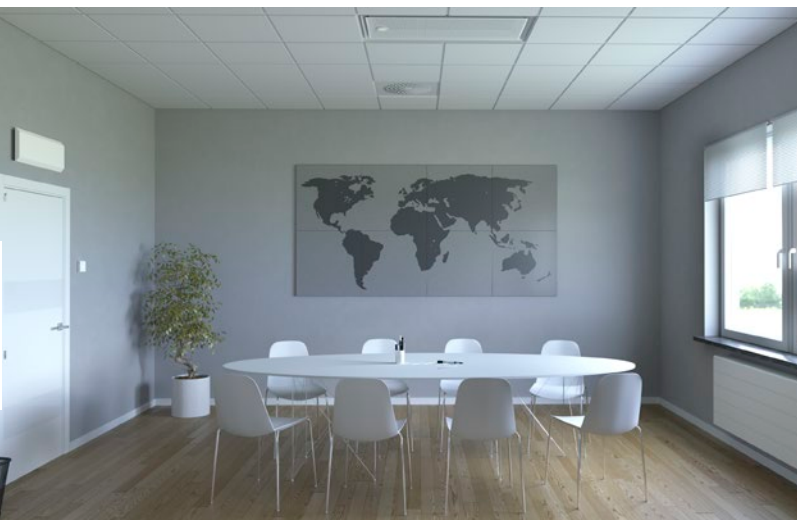
Konferanserom med børverdiratt og behovsstyrt luftregulering samt vannbåren kjøling og styring av radiator.
