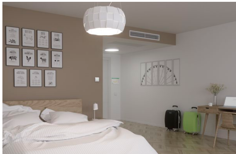
Hotellrum med bõrvärdesomstállare, vattenburen kyla och värme samt behovsstyrd luftreglering. Nyckelkortshállare för nárvaro.
