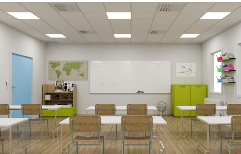
Klassrum med behovsstyrd luftreglering, nárvarogivare samt styrning av radiator.
