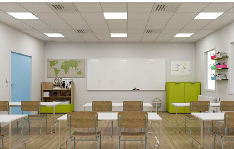
Aula con regulación del aire en función de la demanda, sensores de ocupación y control de radiadores.
