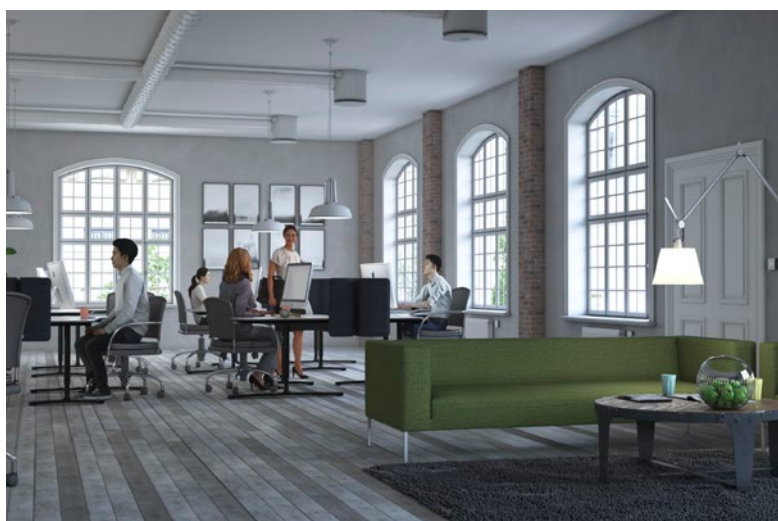
Oficina diáfana con regulación del aire en función de la demanda con selector de valor de consigna y control de los radiadores.
