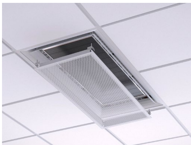
Figur 12. Demontering av underplate for tilgang til batteriet
