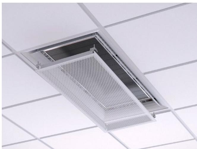
Figure 12. Dépose de la face avant pour accéder à la batterie
